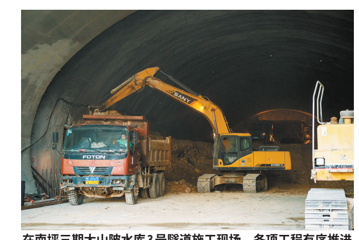
在南坪三期大山陂水库3号隧道施工现场, 各项工程有序推进。
