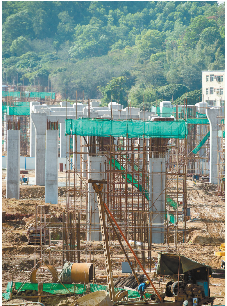
南坪三期锦龙立交施工现场。
